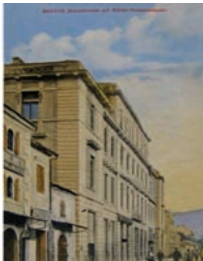
Josip Vancaš: Zgrada Vojne komande u Mostaru (1898.), izvoran izgled (razglednica iz privatne zbirke Šemsudina Zlatka Serdarevića)
